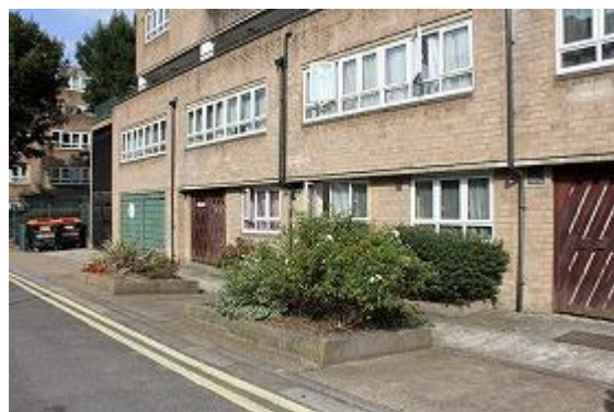
花壇や雨水を利用したプロジェクト現場
